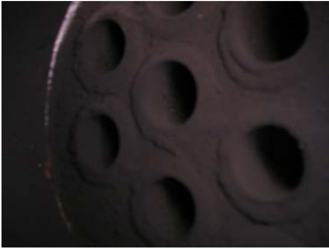
Рис3. Котел. Вид изнутри топки
